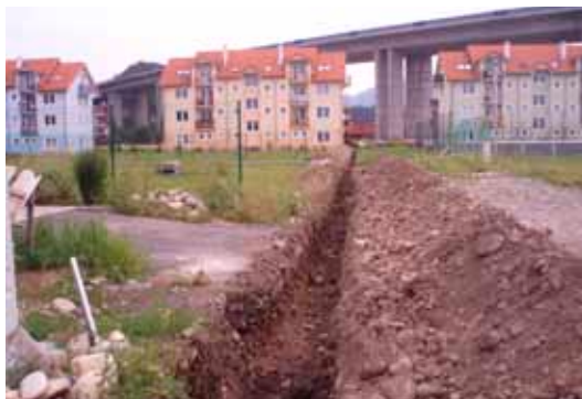
Výstavba plynovodu na ulici O. Jarjabka. V júli obec zabezpečila poslednú etapu výstavby inžinierskych sietí na ulici O. Jarjabka. Vlastníkom pozemkov bolo umožnené pripojiť jednotlivé rodinné domy na plyn
