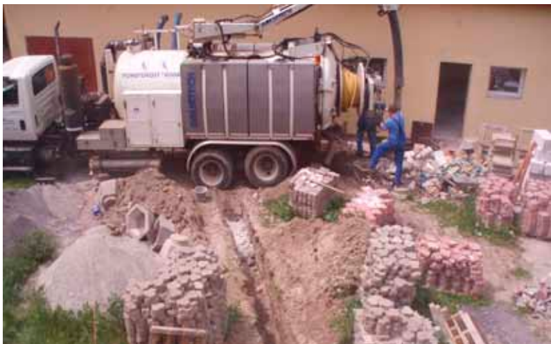
Pred dokončením. Rekonštrukcia knižnice a ďalších zariadení je pred dokončením. Budova je napojená na všetky inžinierske siete. Otázkou sú však tak často skloňované financie
