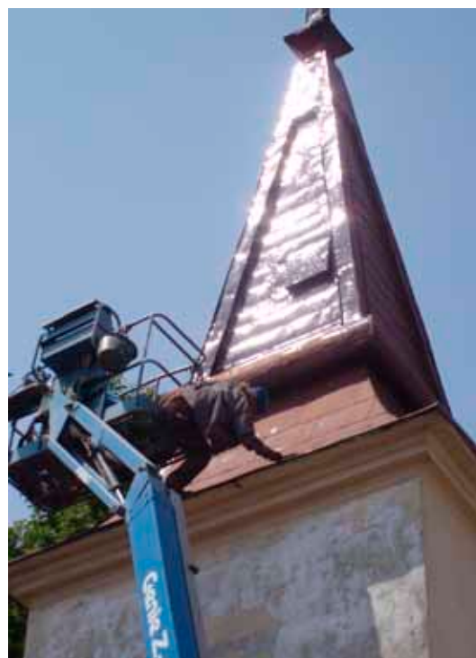
Pracuje sa na nátere strechy
