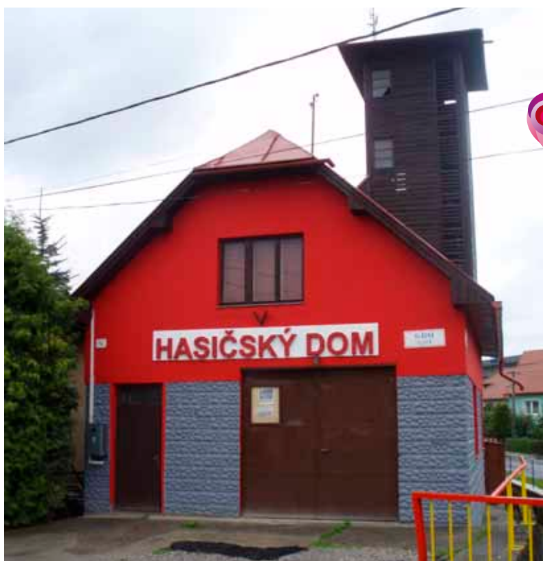
Hasičská zbrojnica po rekonštrukcii
