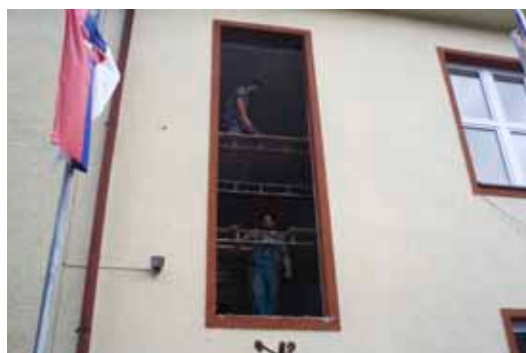
V uplynulých mesiacoch sa opäť pokračovalo na prácach obnovy obecného úradu. Menili sa okná a rozvody kúrenia. Finančné prostriedky boli zabezpečené z ministerstva financií. Budova obecného úradu postupne mení svoj tvar. Výmenou okien, rozvodov kúrenia je popri zhodnotení majetku obce aj perspektíva šetrenia finančných prostriedkov za energie
