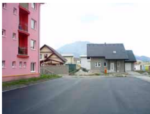
Ulica „Nová“ a parkoviská pri bytových domoch. Ulica „Nová“ bola dokončená a financovaná v rámci výstavby 5×14 b.jednotiek. – obecných nájomných domov
