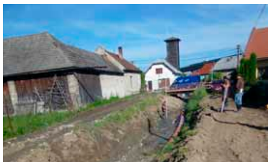
Zemné práce nad mostom. Začalo sa s prehĺbením koryta potoka
