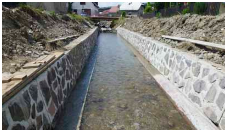
Práce pokračujú úpravou z panelov s kameňom
