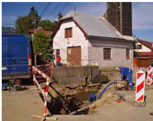
Zahájenie prác pri Požiarnej zbrojnici prekládkou vodovodu
