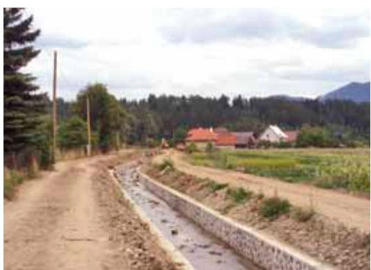
Práce na regulácii dostali nový vzhľad
