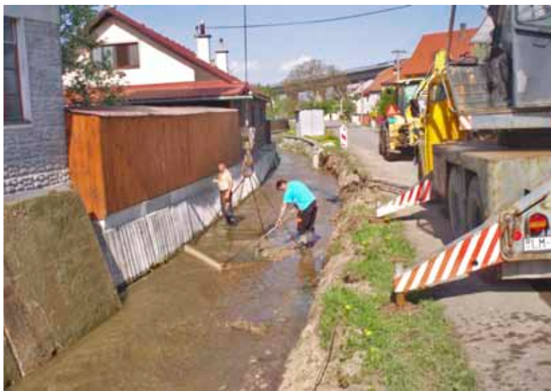
Vyberanie panelov pri Požiarnej zbrojnici, ktoré hatali vodu najmä v zimných mesiacoch
