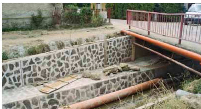
Práce pokračujú úpravou z panelov s kameňom
