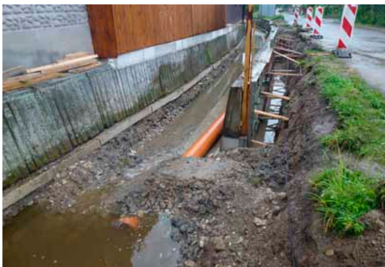
Vyberanie panelov pri Požiarnej zbrojnici, ktoré hatali vodu najmä v zimných mesiacoch
